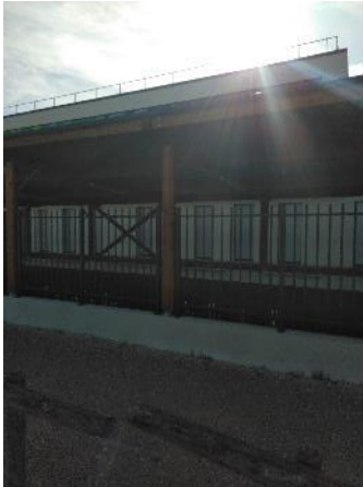
Des « pincés-roues » sont installés dans le collège à Tigy
