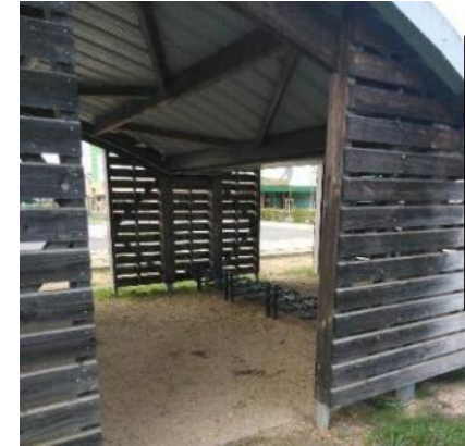
A Darvois, le gymnase intercommunal est doté d'un abri pour les vélos
